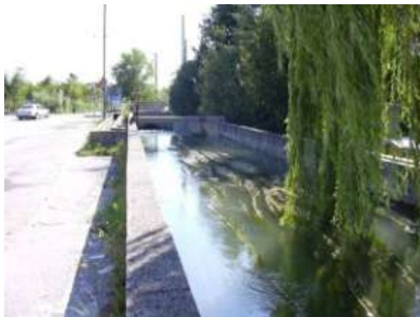
Attraversamento Postumia del Secondario N.1
