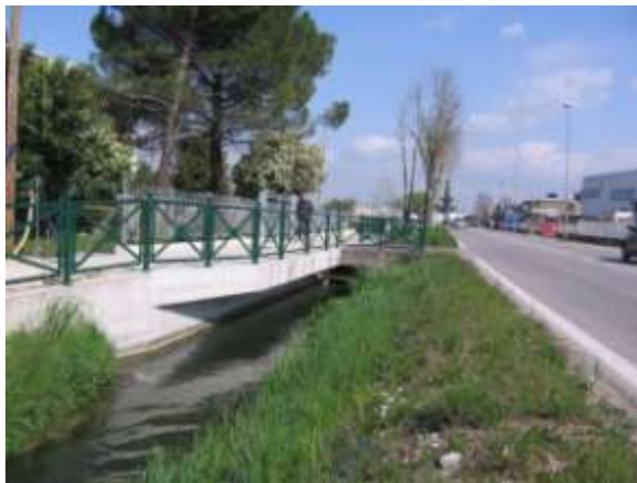
Canale Secondario di Fontane in prossimità dell'area industriale
