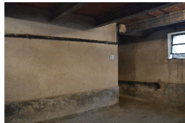
Seminterrato - corpo A
