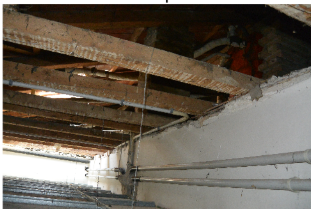
Copertura, sostegno al controsoffitto - corpo A
