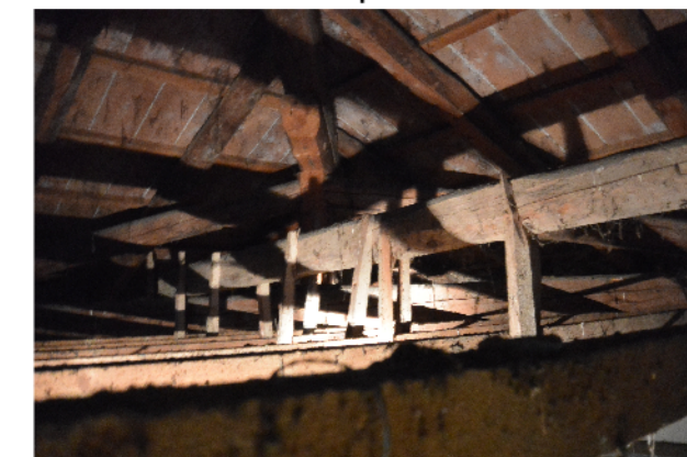
Copertura, capriata rompitratta - corpo A
