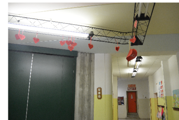
Corridoio di unione tra corpo A e B
