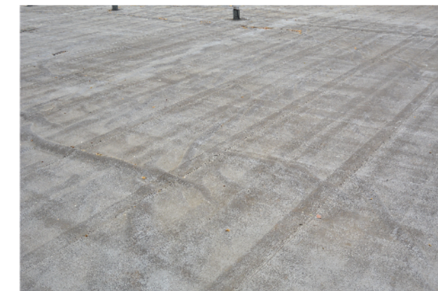
Guaina di copertura - corpo B
