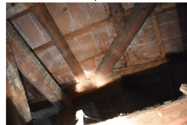
Copertura, Incrocio di travi - corpo A
