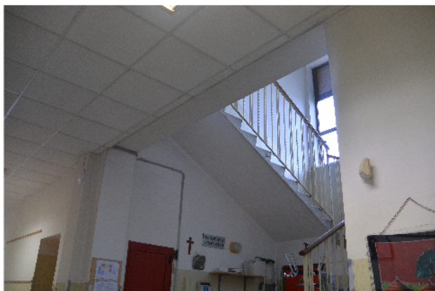
Scala interna - corpo A
