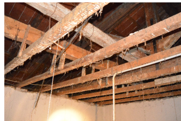
Copertura, Capriata - corpo A
