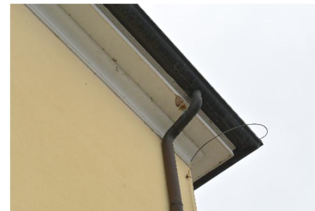
Cornice di copertura - corpo A
