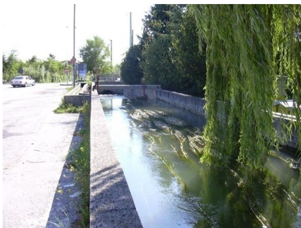
Attraversamento Postumia del Secondario N.1
