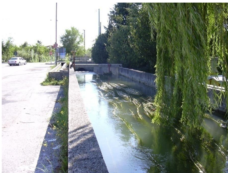
Attraversamento Postumia del Secondario N.1
