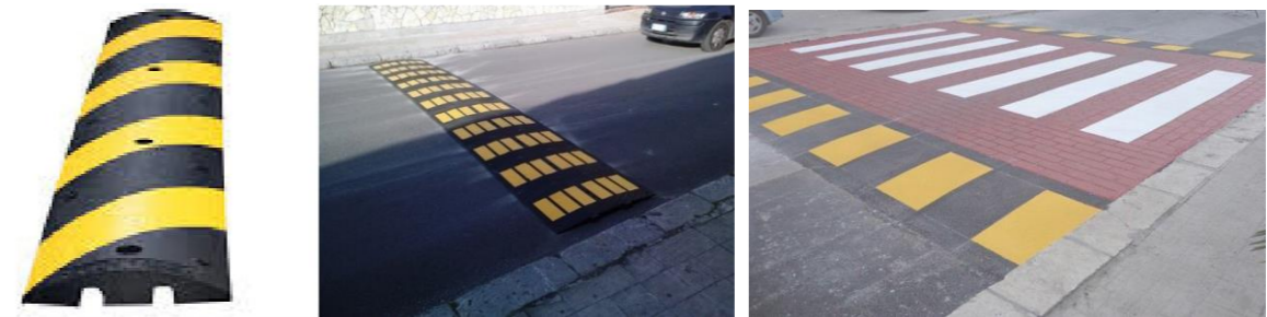
Figura 27: esempio di dossi e attraversamenti pedonali rialzati
