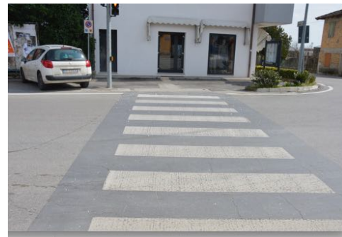
Vernice con microsfere rifrangenti e semaforizzazione
