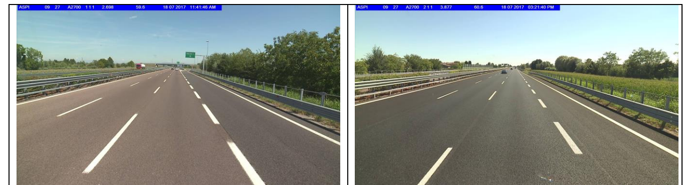
Foto 1 Carreggiata nord, km 3+450
