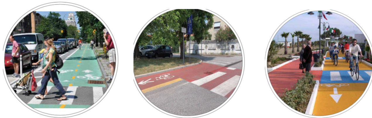
Attraversamento con pavimentazione colorata su bidirezionale in sede propria
